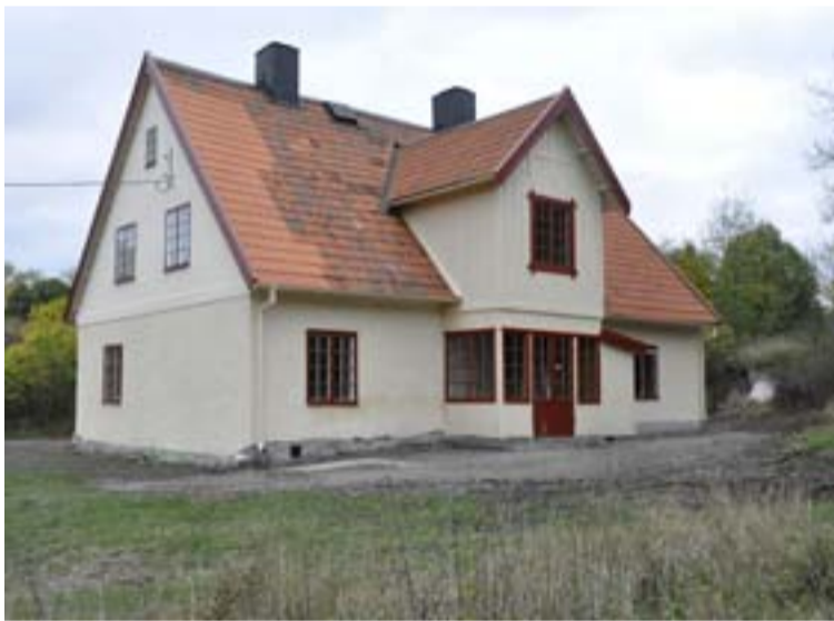
Utsidan av Trädgårdsmästarebostaden har renoverats. FOTO: LENNART JÖNSSON
