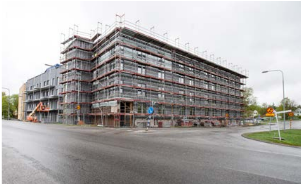
Stora arbetsmiljöproblem och social dumpning på bygget vid Töresjövägen.
